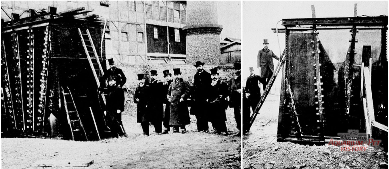
Photographs showing the test tank. Guide-souvenir de l'Aquarium de Paris , 1900. Source: gallica.bnf.fr / Bibliothèque nationale de France, département sciences et techniques.
