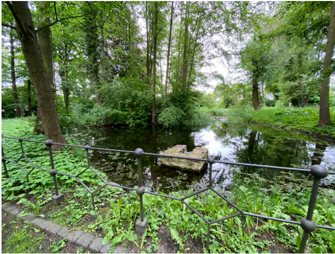
Eine Rohrleitung versorgt den Schäfferteich mit Wasser aus der Ratsrinne
