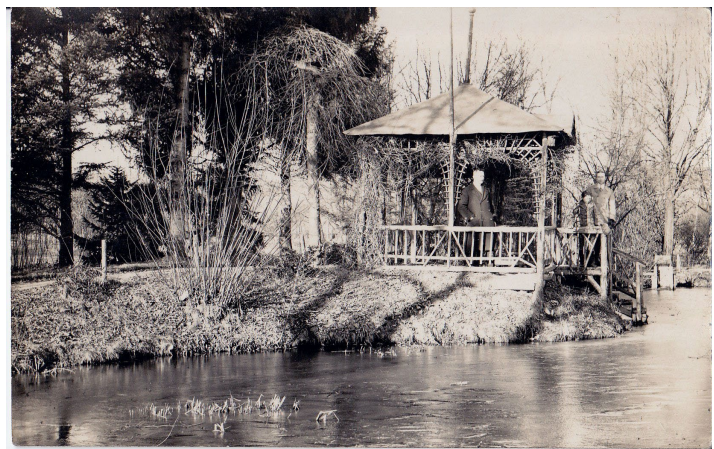
Postkarte mit Ansicht des neben dem Schäfferteich errichteten Pavillons
