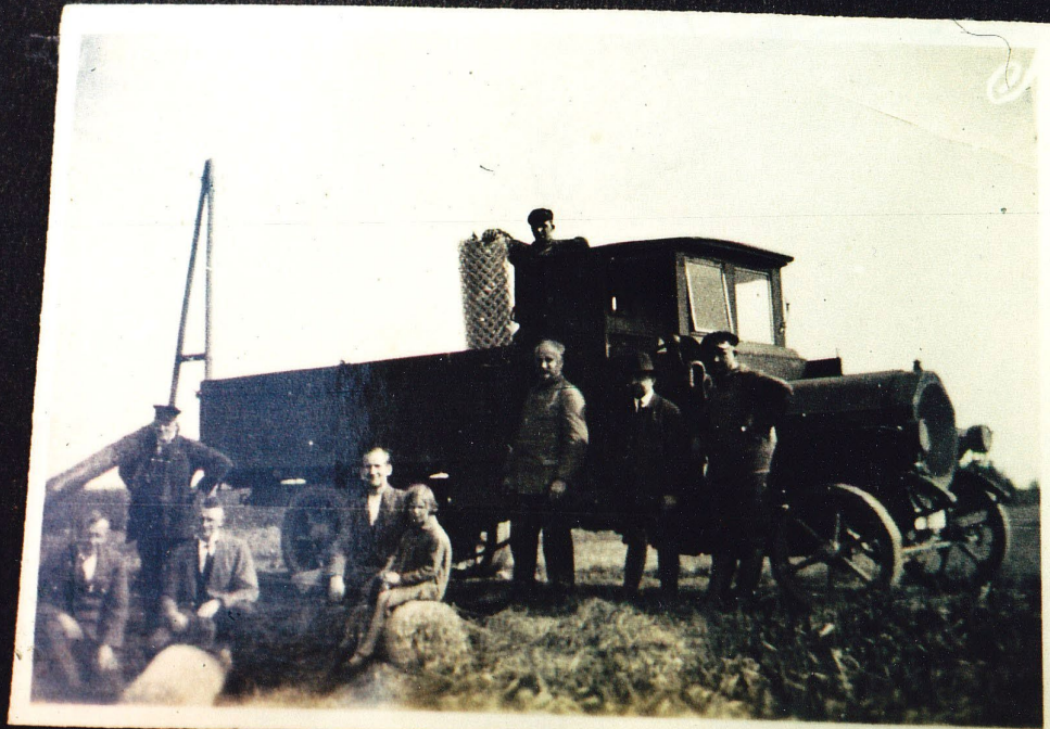
Der erste Spatenstich für die neue Anlage erfolgte am 15. Mai 1927
