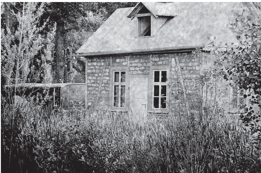
Der unverputzte Rohbau des Hauses war fertig
