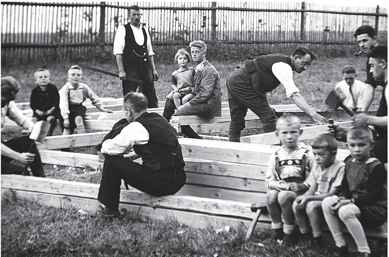
Als letzte Maßnahme wurde das kleine Vereinshaus hinter dem ersten Teich errichtet
