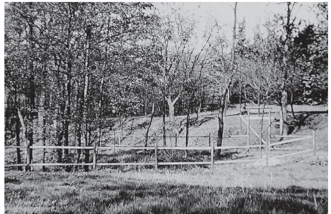
Damit bei den Arbeiten die wenigen bestehenden Baumgruppen nicht zu Schaden kommen, wurden sie vorsorglich mit provisorischen Zäunen umgeben
