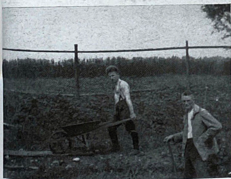
Schwere Arbeit, Teich 4 wird ausgeschachtet
