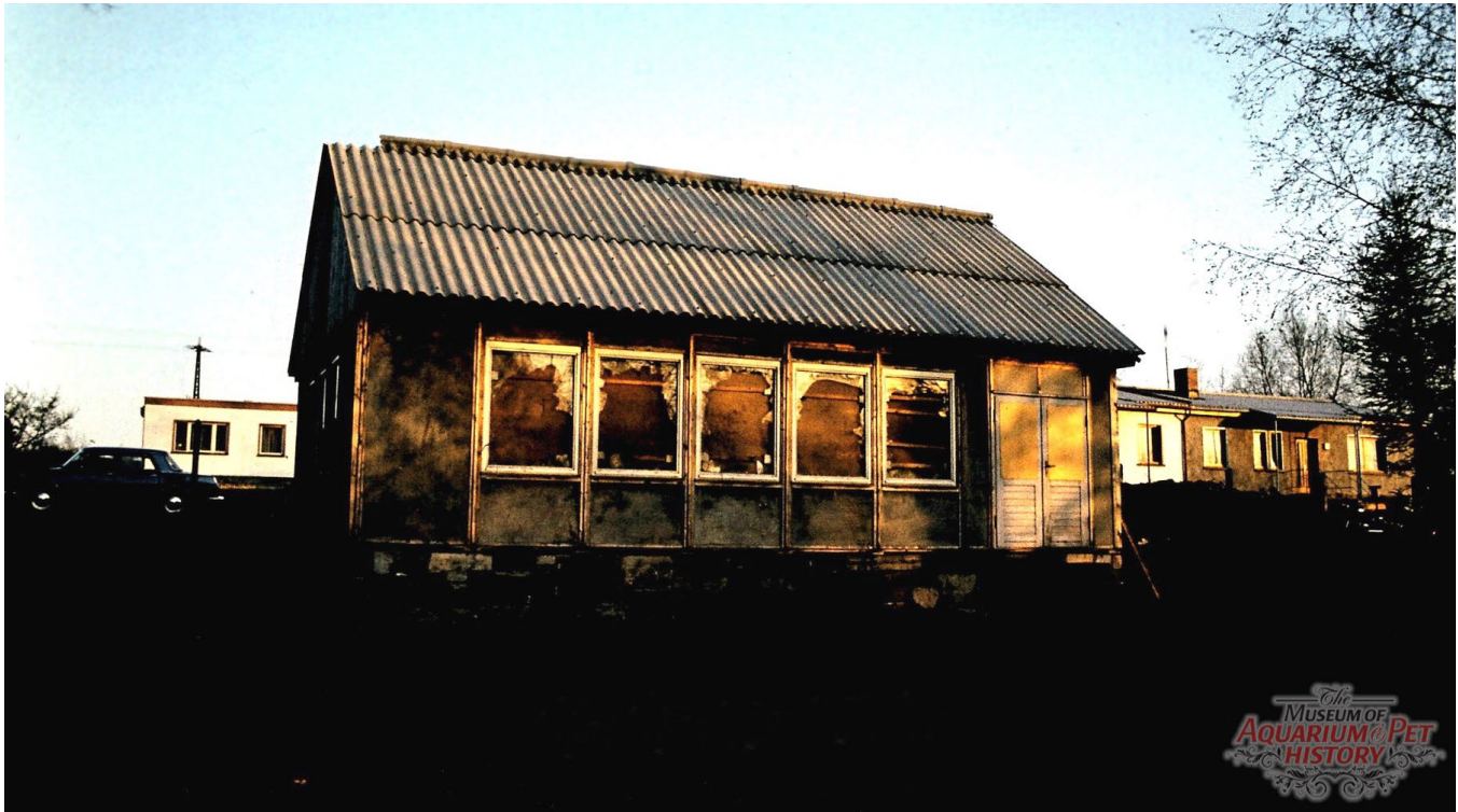
Durch Vandalismus wurde das Vereinsgebäude in den 70er-Jahren stark beschädigt
