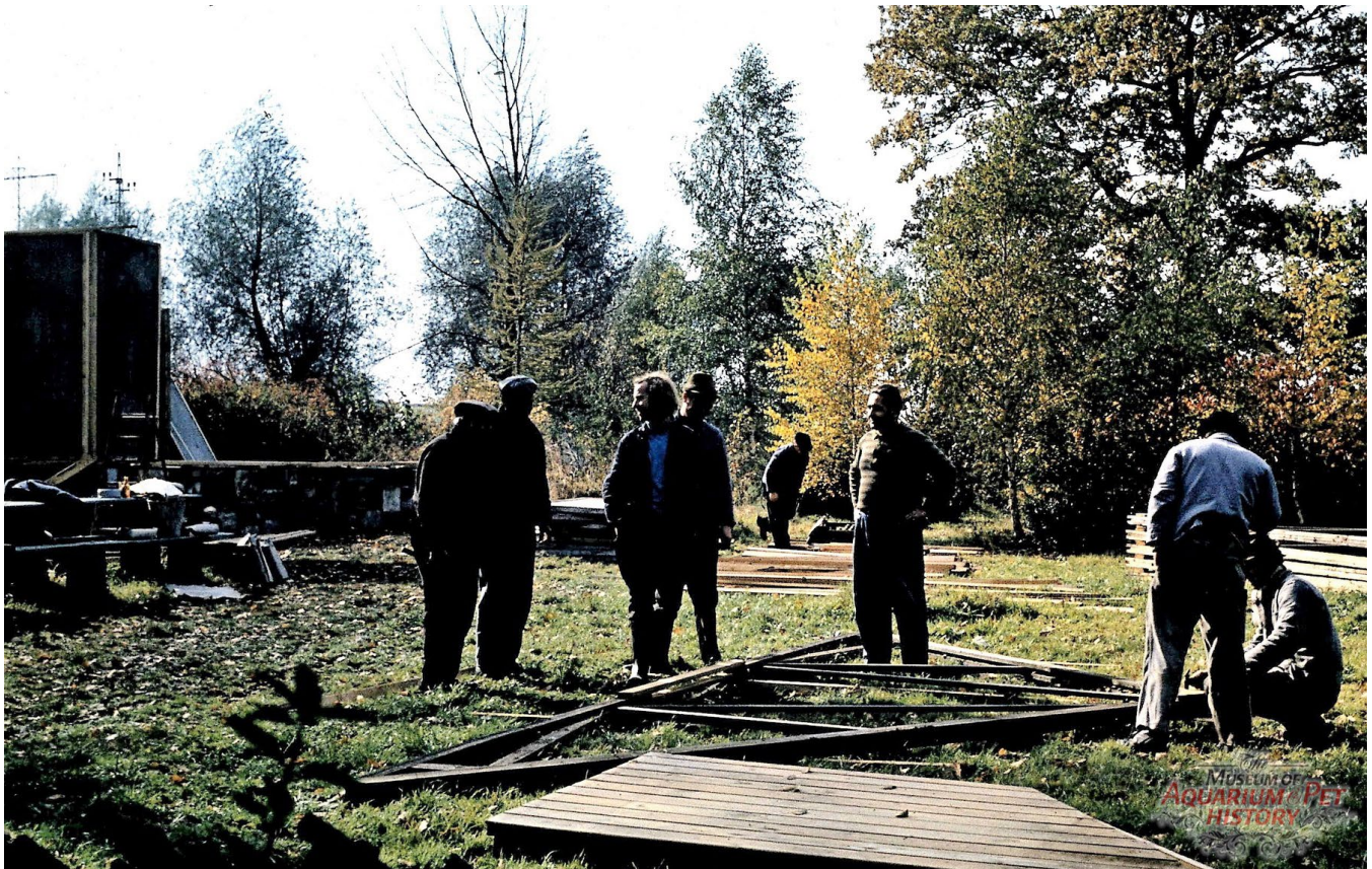
Aus Fertigteilen wird das barackenähnliche Gebäude für den künftigen Vereinsraum zusammen gesetzt
